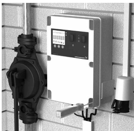
Рис. 8 Монтаж шкафа управления LC 221
