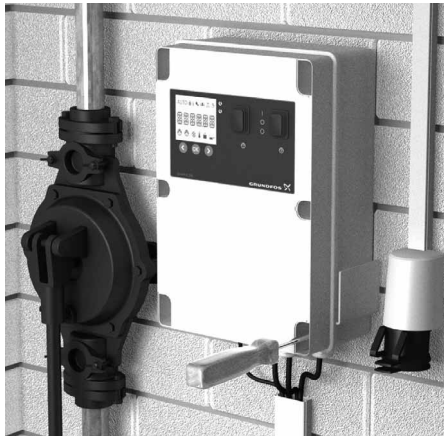
Рис. 10 Монтаж шкафа управления LC 221
